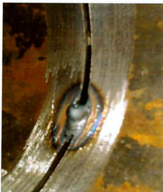
Figura 4.5 – Perfuração ocorrida na soldagem CP2 abertura de raiz 4,5 mm
